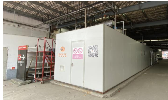
有机废物发电项目 中国上海
